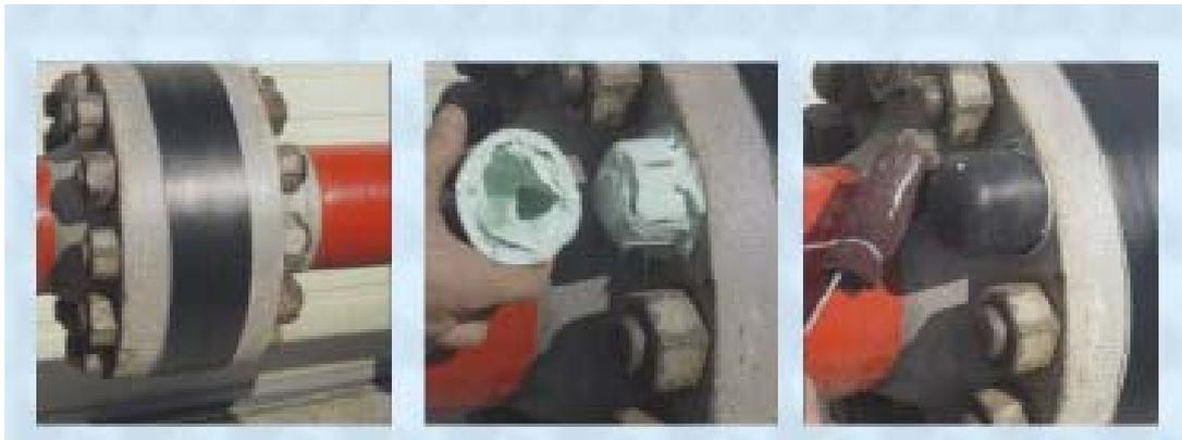
图 7 站场地面法兰螺栓腐蚀防护
