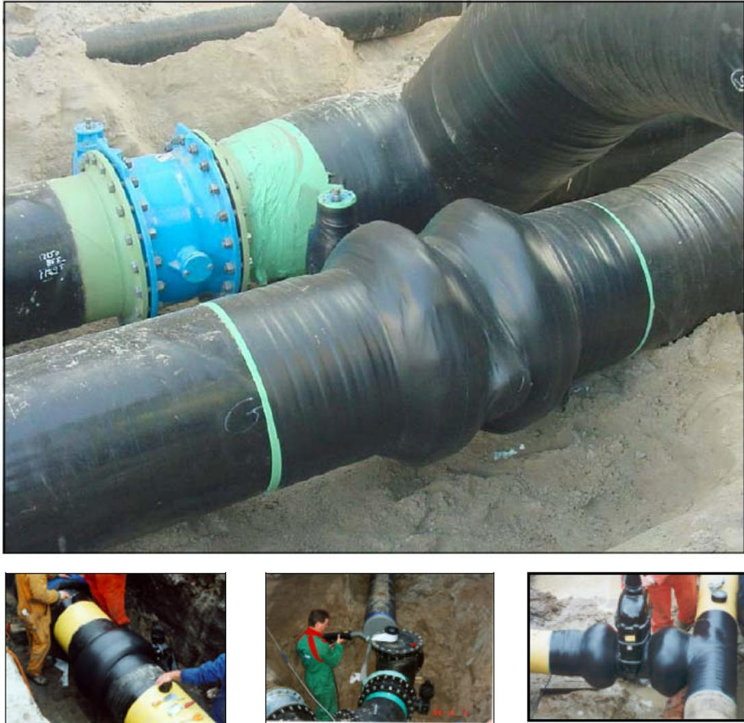
图 5 用于埋地阀门、法兰等设施
