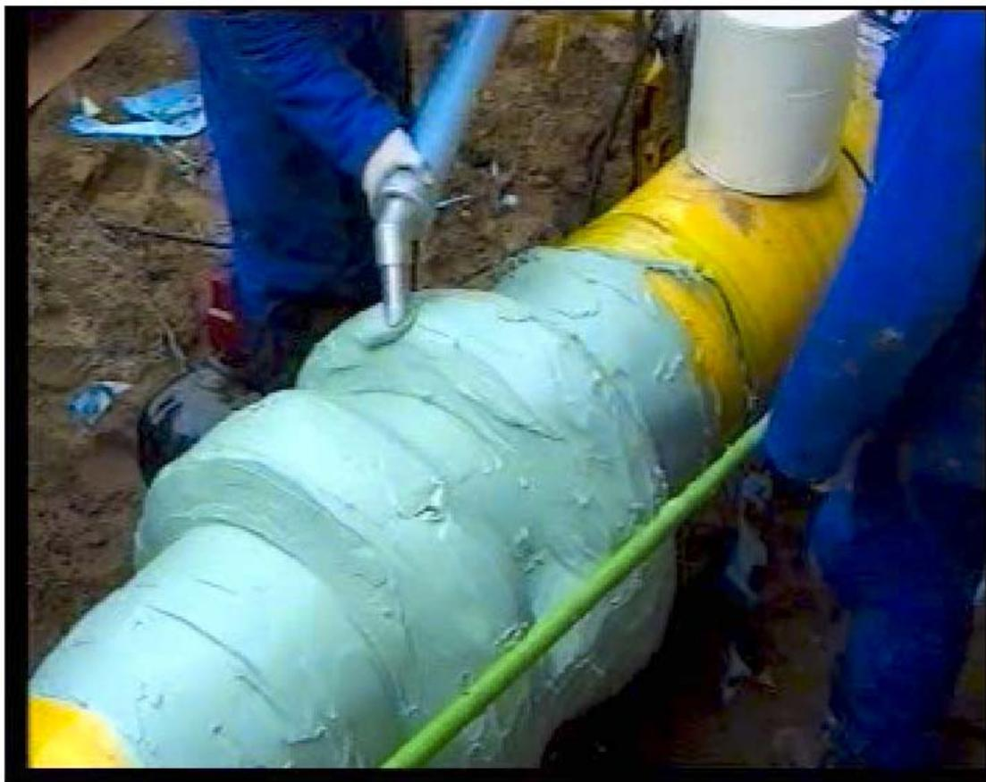
图 12 埋地绝缘法兰防腐
