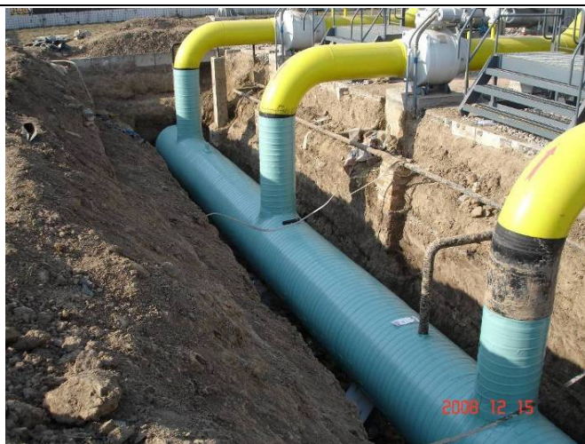
十、西南油气田埋地阀门防腐
