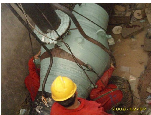
十二、荷兰天然气站场使用
