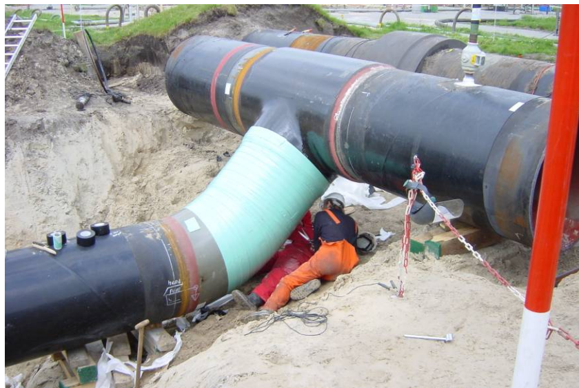
三、 站场埋地管道、阀门、大小头等异型管件现场防腐
