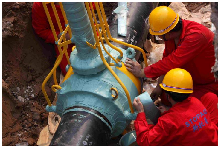
十一、中海油广东燃气埋地球阀防腐
