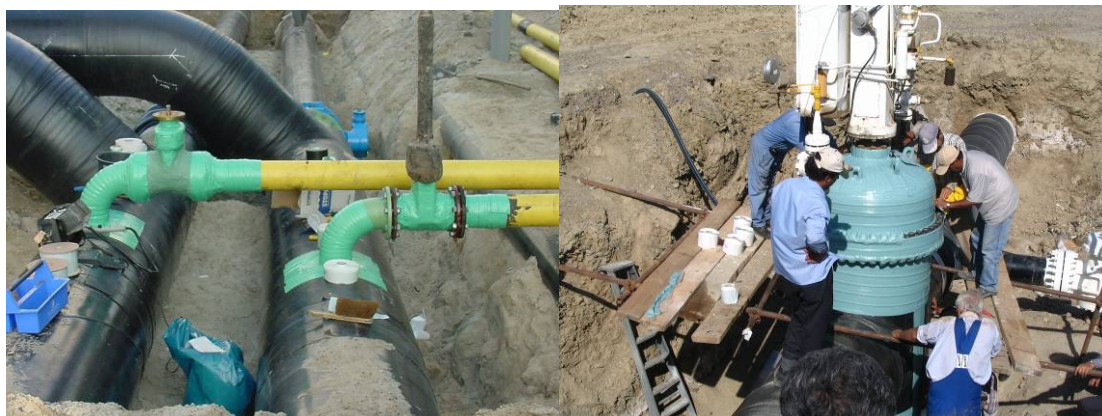
四、 法兰间隙密封防腐
